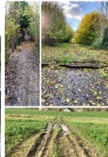
Aménagements de sentiers
