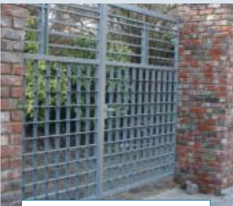
Ath, piétonnier Siron, nouvelle grille.
