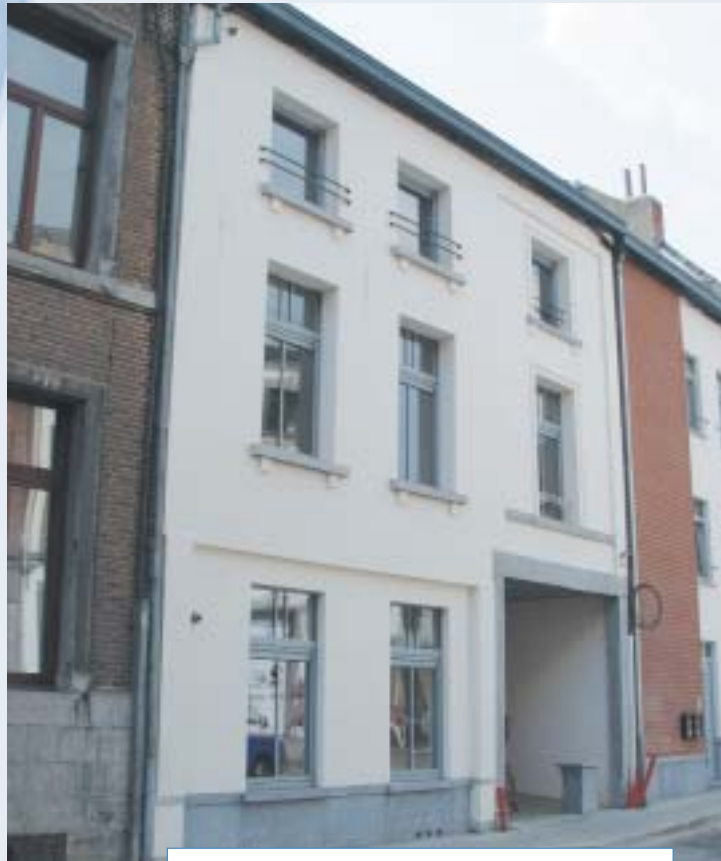
Rue des Récollets : habitation rénovée
