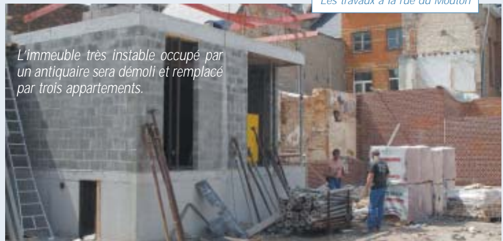
Les travaux à la rue du Mouton
