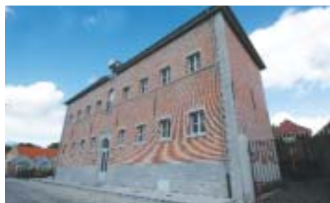
La brasserie Rivière (Maffle) vient d'être rénovée par l'Institut du Patrimoine Wallon.
