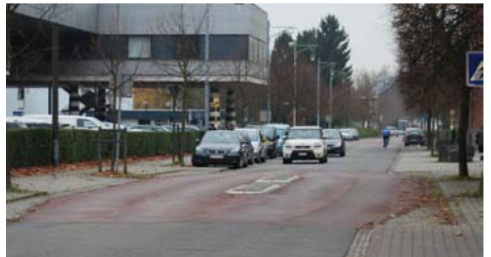
Deux tronçons de la Rue Maria Thomée ont également été remis à neuf
