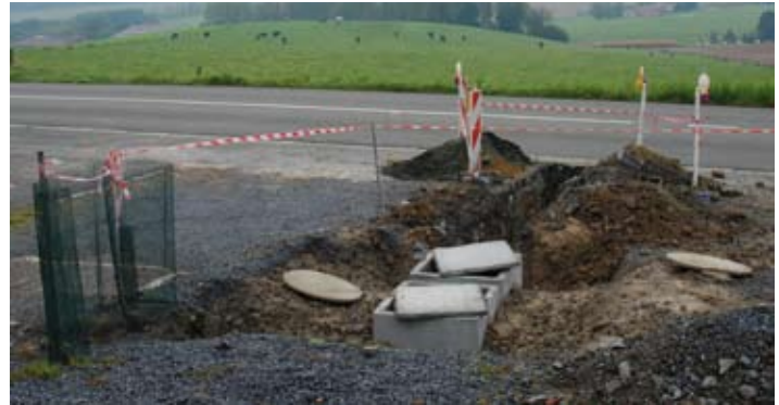
A la rue du Mont à Mainvault, la Régie communale a procédé à un raccordement aux égouts de maisons situées en amont de la route.
