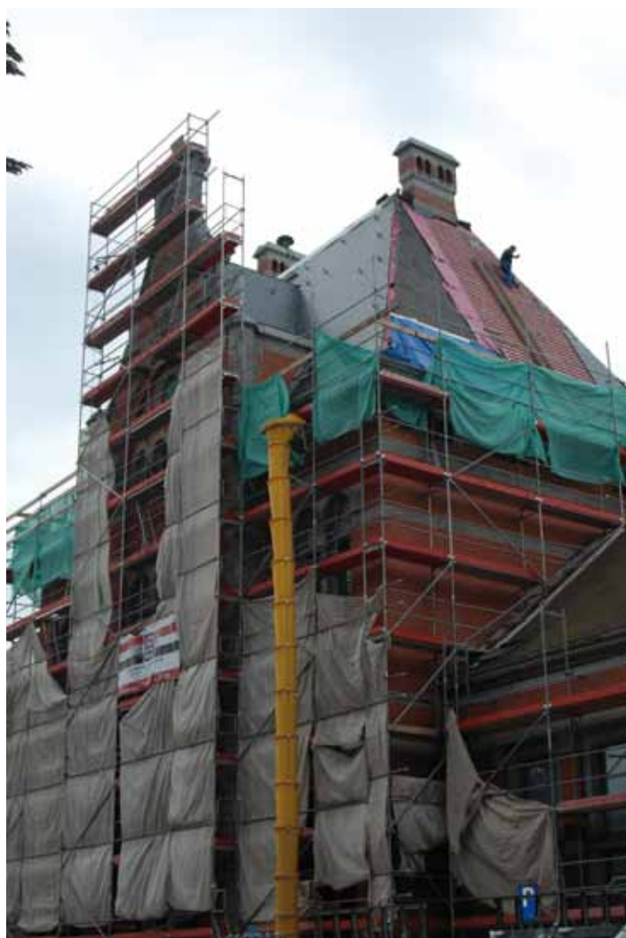
La gare d'Ath retrouve peu à peu tout son éclat, tant au niveau de ses façades que de la toiture
