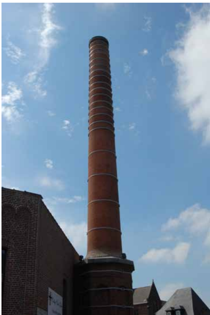
Les travaux de restauration de la cheminée rue de Dendre sont terminés.
