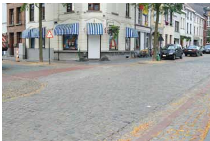
Les travaux de pavage des 4 carrefours de la rue de Pintamont ont été effectués durant l'été. L'état de la rue était donc optimal pour le passage de nos géants.
