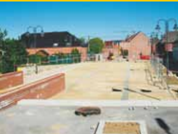
La place du petit casino. Quel beau chantier!
