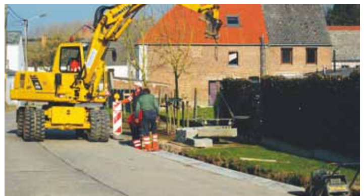
Des filets d'eau ont été posés ou remplacés à de nombreux endroits, comme ici, à Moulbaix.
