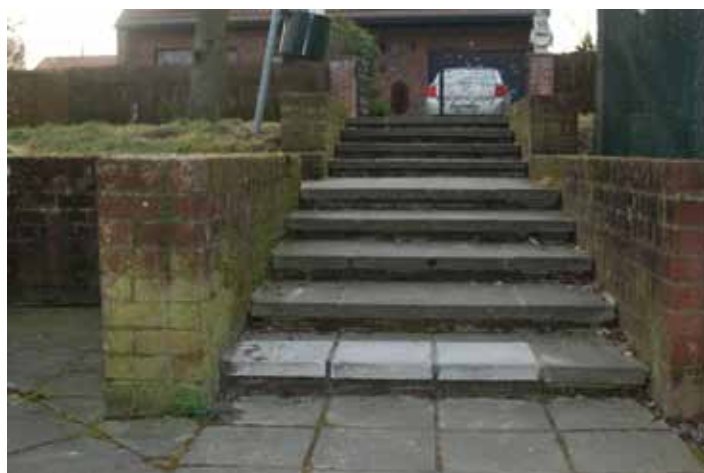
Les travaux d'entretien des trottoirs sont permanents, comme ci-dessus avec l'escalier à proximité de l'école du Faubourg de Tournai. Si vous remarquez une situation plus délicate ou dangereuse, merci d'en informer nos services via info@ath.be ou au 068/26.91.00.
