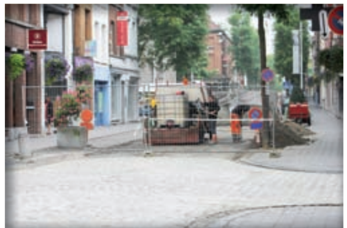
Dernier acte pour les réparations de voirie rue de Pintamont.
