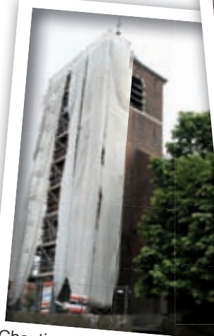
Chantier de rejointoiement en cours à l'église de Bouvignies.
