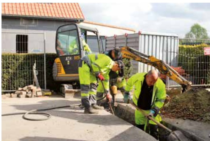
Raccordement au réseau d'égouttage à Moulbaix.
