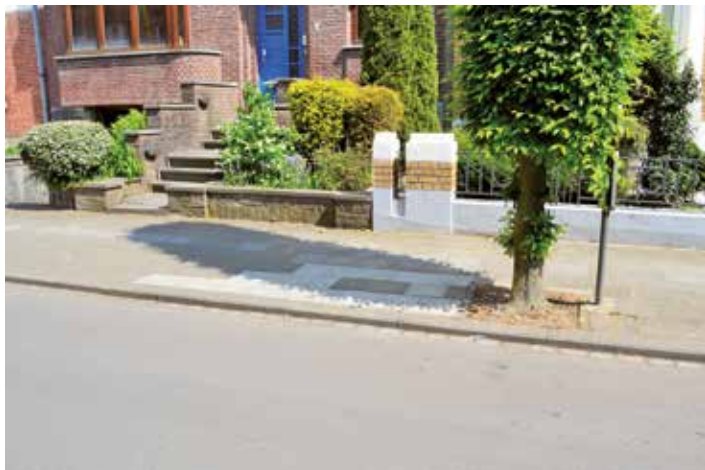
Réfection de trottoir à l'avenue Léon Jouret.
