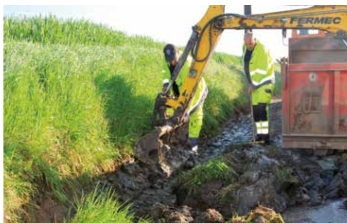
Au chemin de Magenies à Ostiches, un filet d'eau en pavés a retrouvé la lumière.
