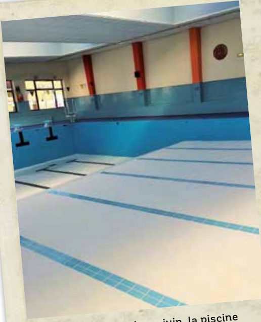
Comme chaque année en juin, la piscine communale a été vidée entièrement afin de procéder à son entretien, plus particulièrement au niveau de la coque du bassin.
