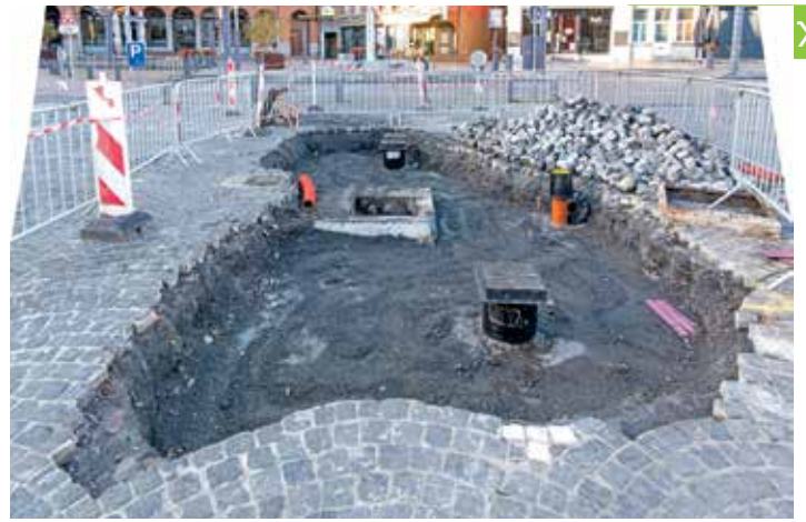
Remplacement des structures des coffrets électriques sur la Grand-Place.
