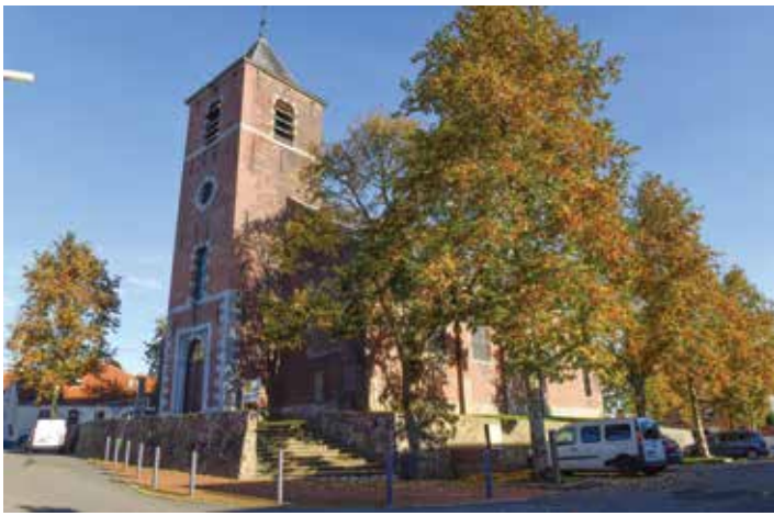
Dépigeonnage et nettoyage du clocher de l'église de Bouvignies. De nouveaux filets seront posés sur les abat-sons afin d'éviter ce problème.
