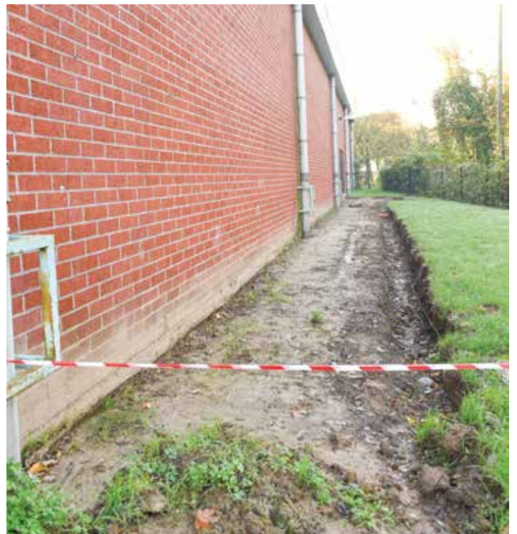
Réalisation d'un trottoir à l'arrière du hall Marcel Denis.
