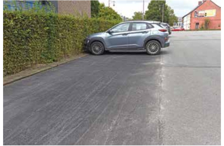
Réalisation d'un accotement en hydrocarboné à la rue du Rivage à Ath
