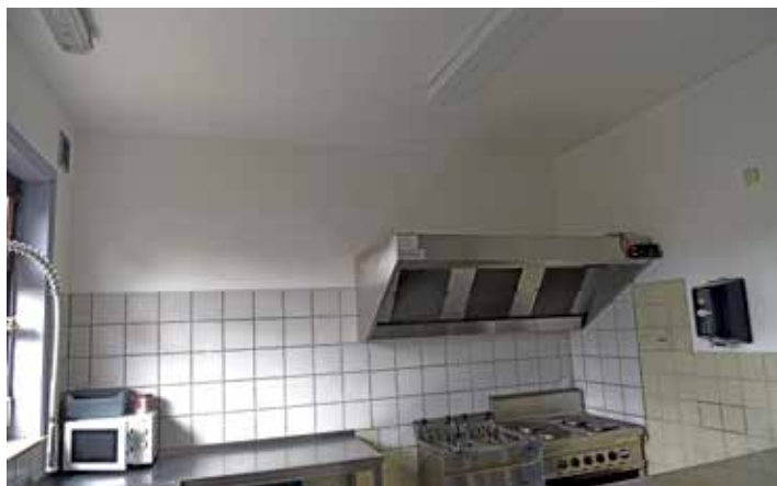
La cuisine de l'école de Mainvault a été repeinte par les ouvriers communaux
