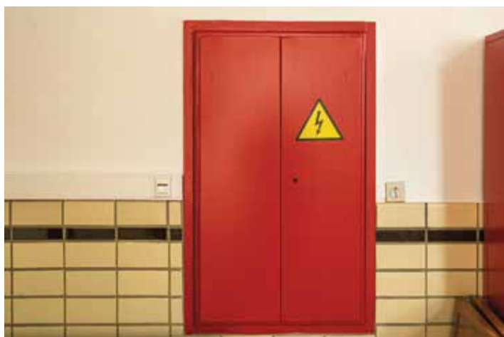
Remise en état complet des installations électriques de l'école de Georges Roland (éclairage et tableaux électriques).
