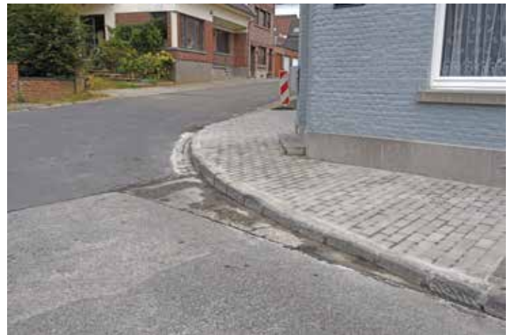
Remise à niveau de bordures et d'un trottoir à la Place de Maffle
