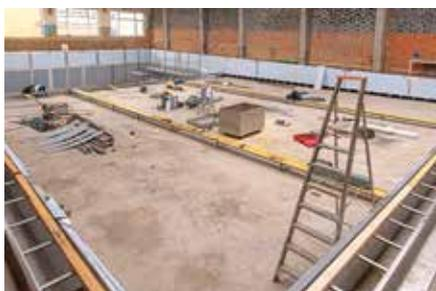
Pour ce qui est de la piscine proprement dite, le gros œuvre des vestiaires a été réalisé. Les parois verticales en inox du bassin sont presque terminées également. Le fond de bassin est prévu pour novembre.
